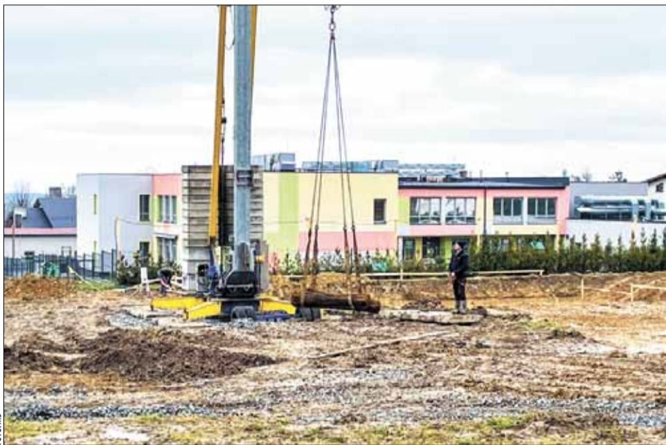
Z każdym kolejnym tygodniem postępuje budowa nowego przedszkola przy ulicy Lipowej w Kozach.
