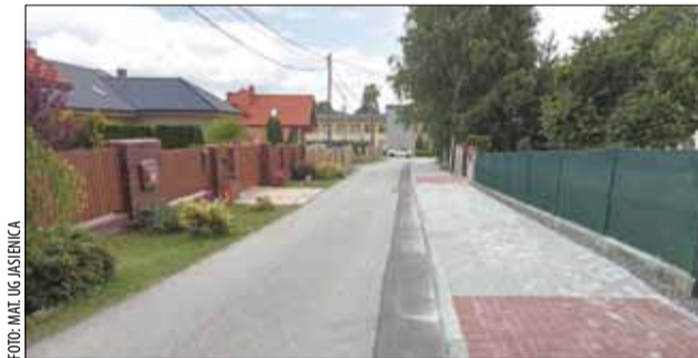
Wykonany chodnik wzdłuż ul. Zapłocie poprawia bezpieczeństwo pieszych idących do szkoły w Międzyrzeczu Górnym.
