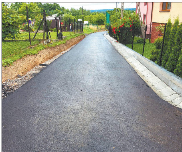
Ulica Osiedlowa w Bujakowie po modernizacji.
