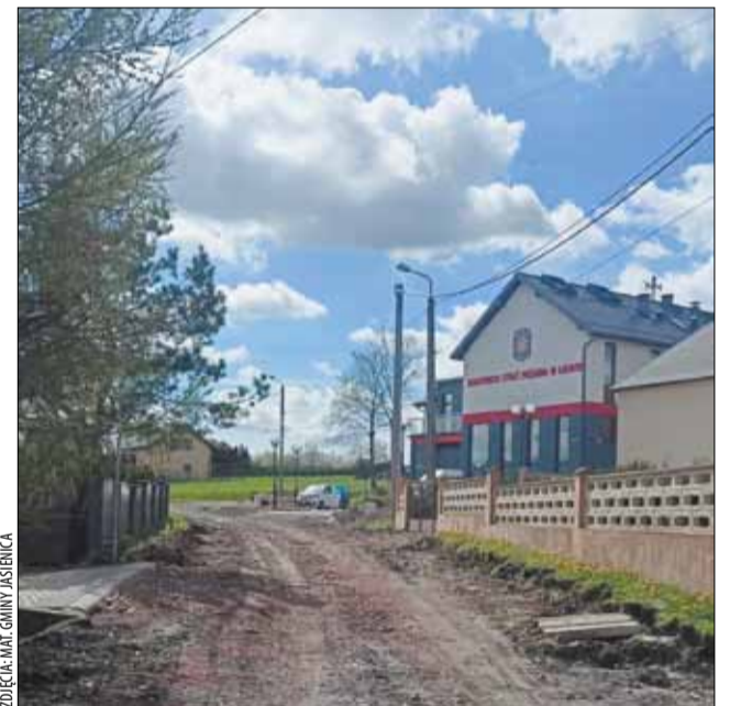
Trwają prace przy przebudowie fragmentu ulicy Kościelnej w Łazach.
