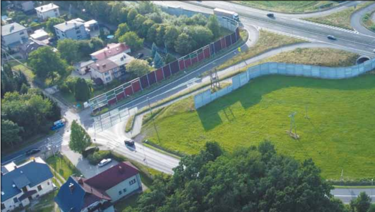
Zdjęcie z częścią węzła S52 w Jasienicy, przed przebudową. Planowane zmiany obejmują m.in. modernizację zjazdu i wjazdu oraz utworzenie ronda koło biblioteki.
