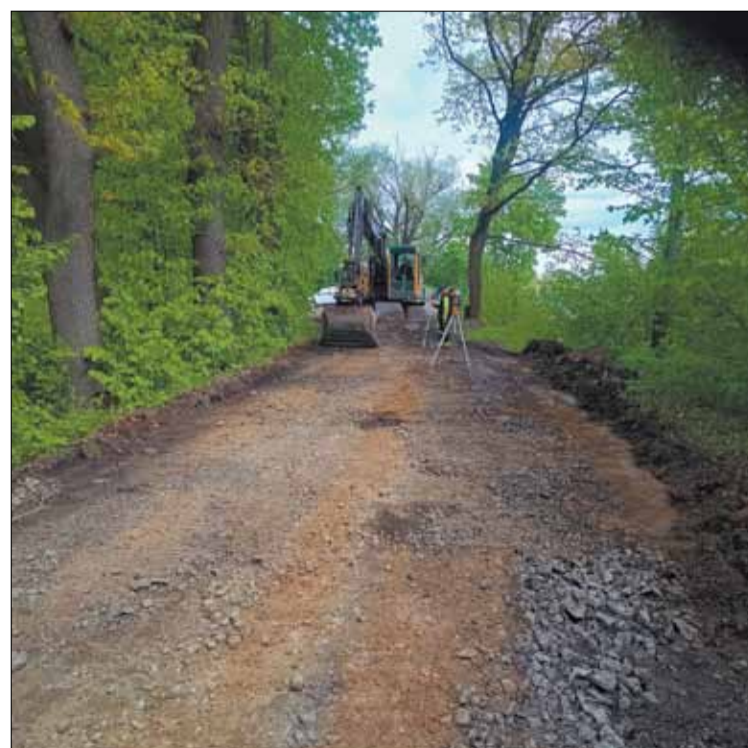
Remont ulicy Pierścieckiej w Roztropicach.
