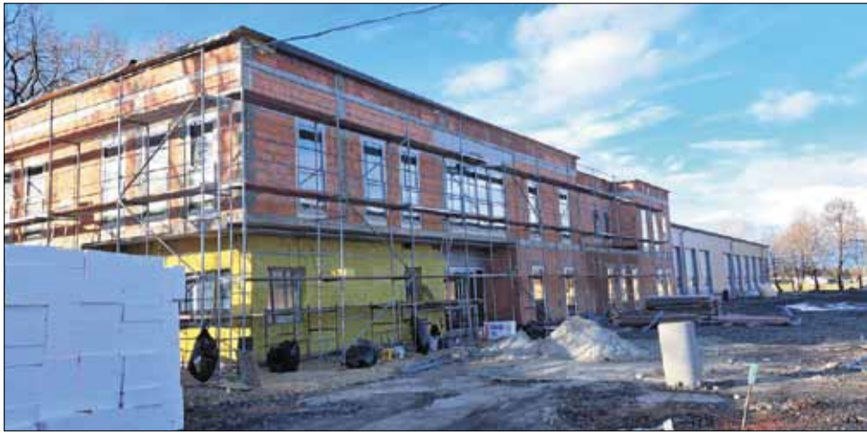
Trwają prace przy budowie Zakładu Komunalnego i zaplecza garażowego dla samochodów asenizacyjnych.
