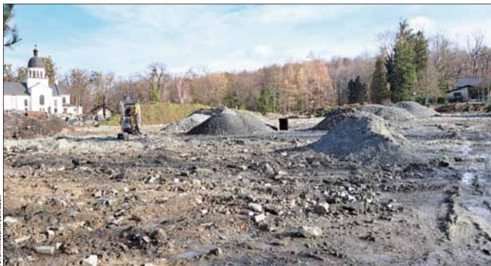
Wykorzystując sprzyjającą aurę wykonawcy wznowili prace przy budowie dużego parkingu przy ul. Wapienickiej.
