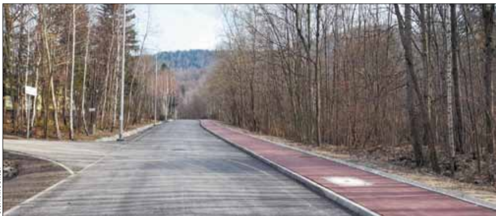
Przebudowana ulica Piaskowa prowadząca do kamieniołomu to teraz m.in. szersza jezdnia z nową nawierzchnią asfaltową.
