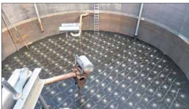
Próba systemu napowietrzania w SBR II.
