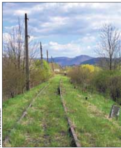
Linia kolejowa przebiegająca przez gminę Jasienica zostanie praktycznie wybudowana od nowa.
