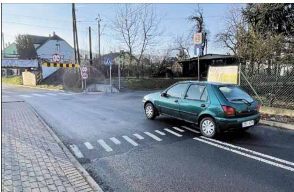
Na skrzyżowaniu ulic Mostowej z Nadbrzezną wykonano tzw. wyniesione skrzyżowanie, które wymusza na kierowcach zmniejszenie prędkości.
