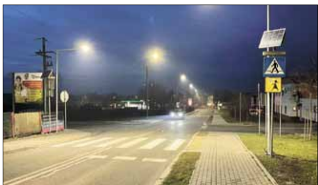
Dodatkowe ledowe oświetlenie przejść dla pieszych zamontowane zostało w ciągu ul. Przeznacznej.
