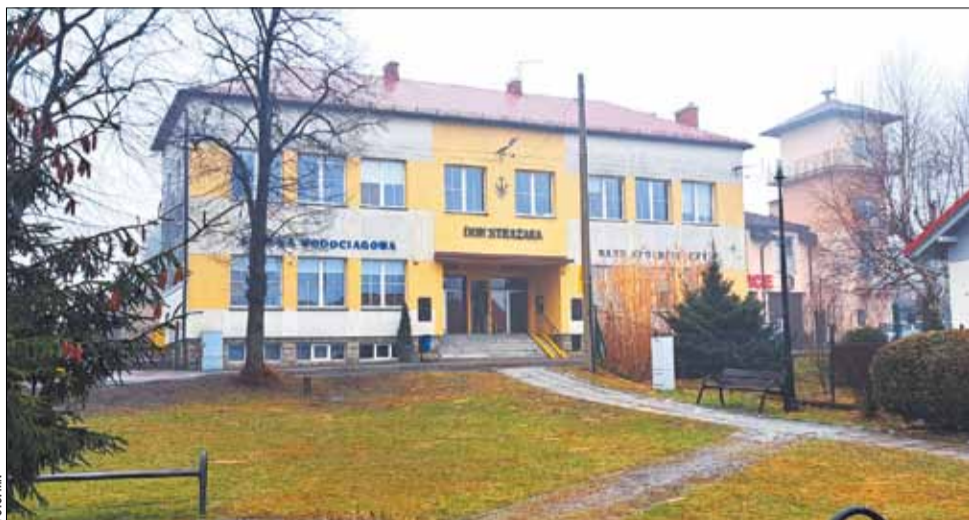
Wśród tegorocznych inwestycji przewidziano remont dachu budynku OSP w Wilkowicach, a w razie przyznania środków zewnętrznych również pierwszy etap modernizacji pobliskiego skweru.
