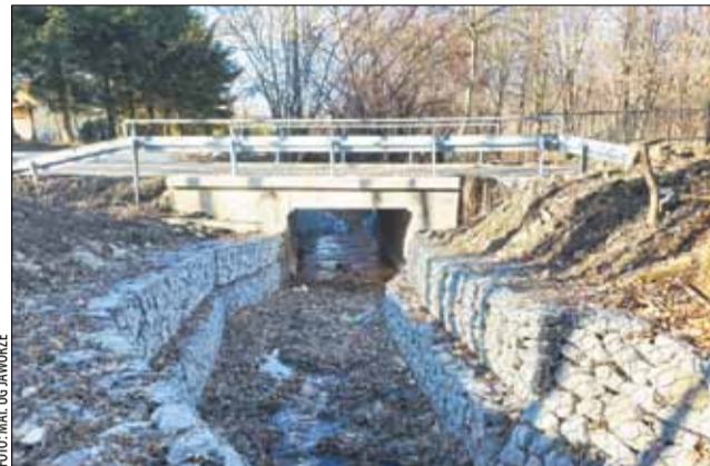
W ciągu ul. Podgórskiej przebudowany został przepust, co znacząco poprawiło bezpieczeństwo w tym rejonie.
