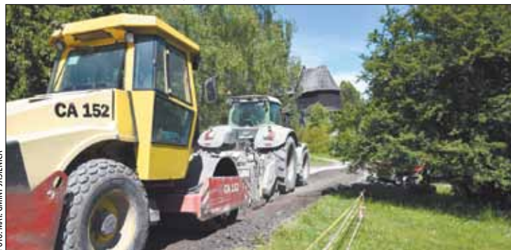
Remontowana droga w Bielowicku
