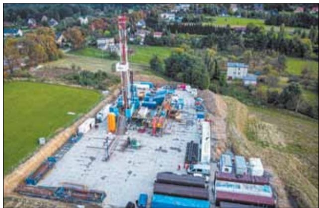
Odwiert do źródeł geotermalnych w Grodzcu.
