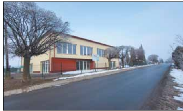
Budynek nowego segmentu dydaktycznego Zespołu Szkolno-Przedszkolnego w Iłownicy.
