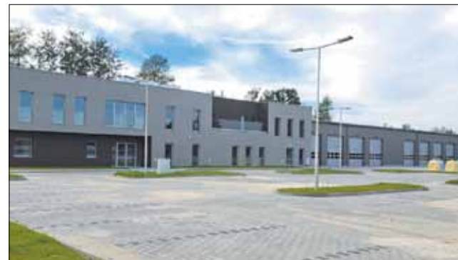
Budowa Zakładu Komunalnego w Jasienicy wraz z funkcjonalnym zapleczem.
