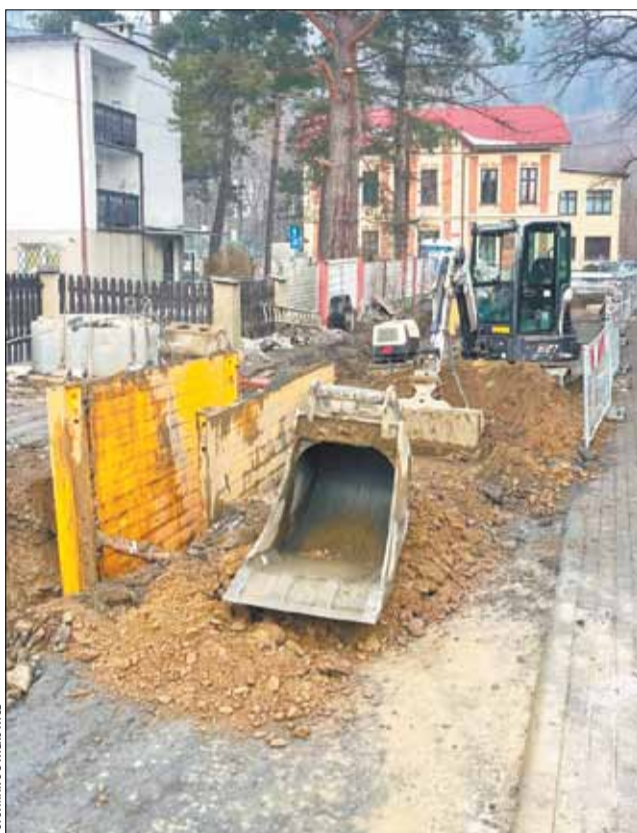
Wzmoczone prace drogowe prowadzone są obecnie na ulicy Kościelnej w Bystrej, na odcinku od ul. Klimczoka do ul. Pogodnej.
