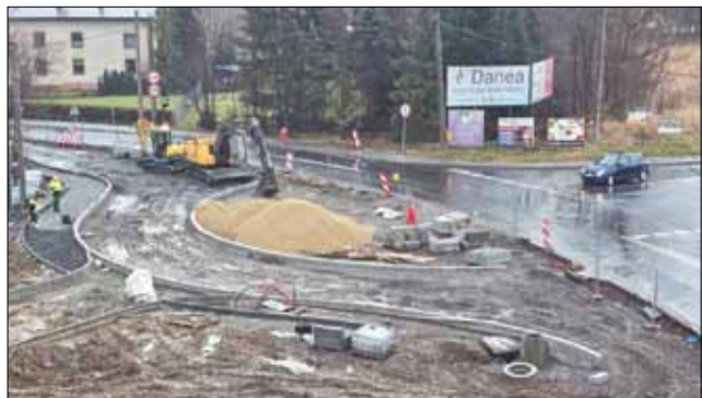
Rozbudowa układu drogowego w sąsiedztwie węzła drogi ekspresowej S52 w Jasienicy.
