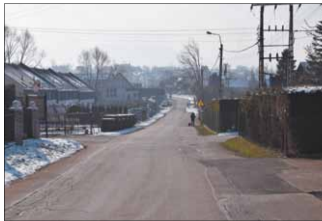
Rozbudowa ul. Astrów w Jasienicy.
