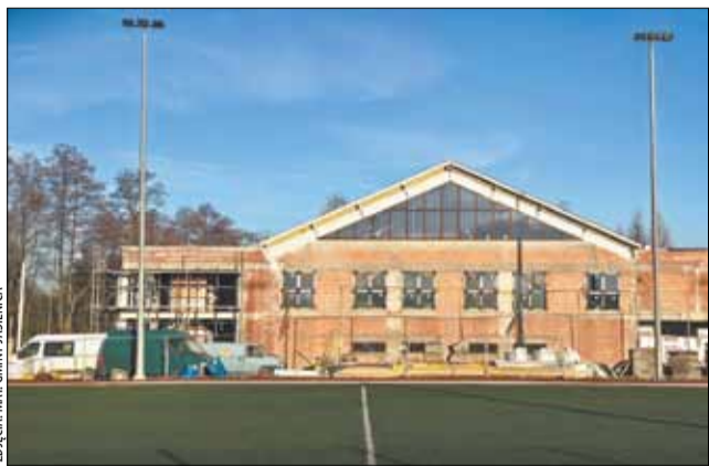
Przebudowa hali sportowej w Jasienicy.
